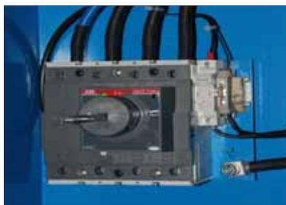
La presa anti-infortunio con blocco elettrico garantisce la massima sicurezza durante le operazioni di connessione e disconnessione che avvengono sempre in assenza di tensione.
